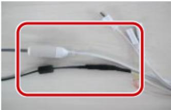
3 Обмотайте остальные кабели изоляционной лентой.
